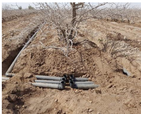
شکل ۲- نحوه اجرا و کارگذاری لوله‌ها در مزرعه
